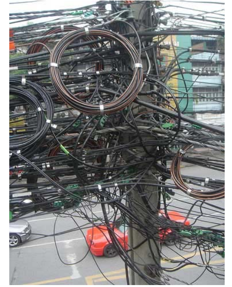
Freileitungen verlegen Kein Problem!
